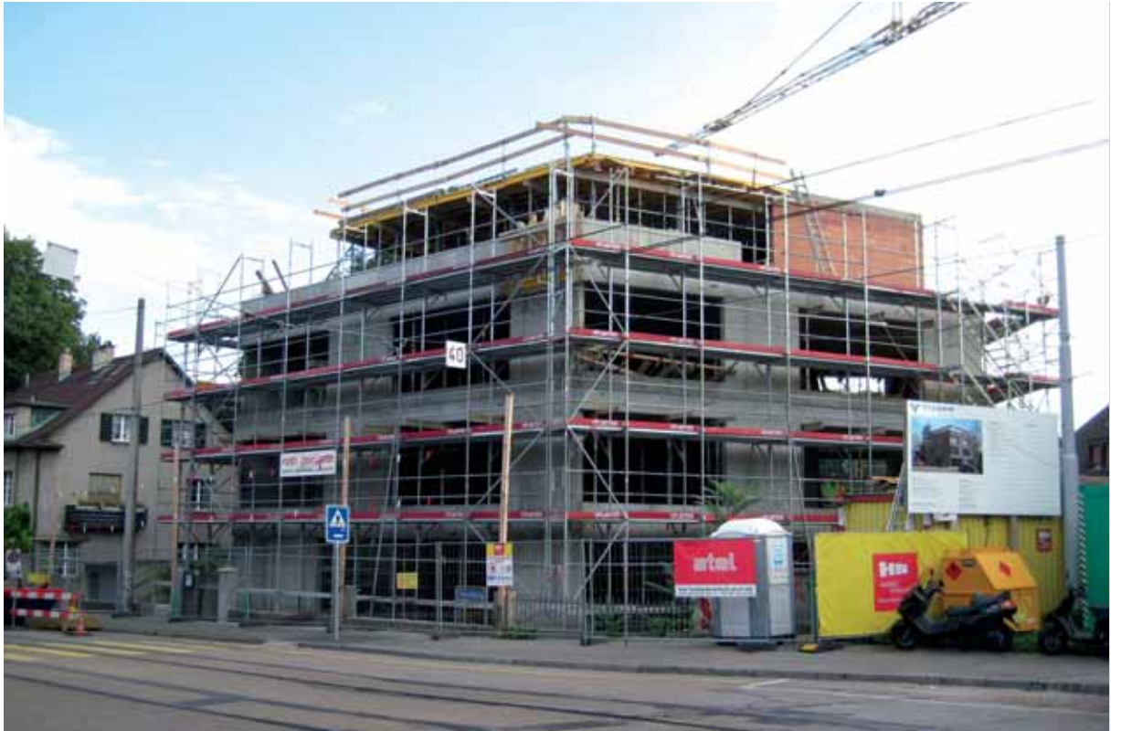
Bild > Baustellenfoto, August 2008
